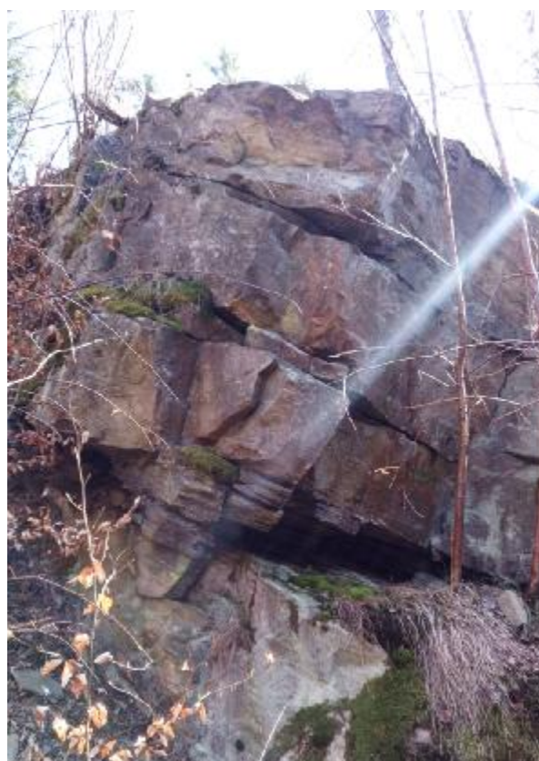
Obr. 12 Pohled na skalní výchoz s převislou odlučnou plochou podél hladkého průběžného puklinového systému (podél tohoto systému dochází k překlápění bloků směrem po svahu do prostoru provozované drážní cesty)
